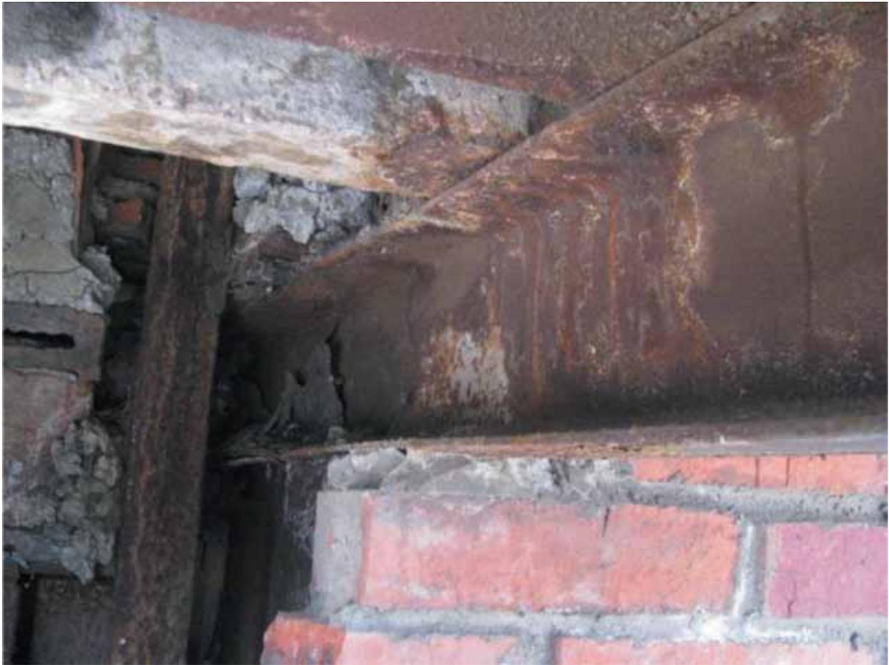
*Фото №2. Фрагмент стальной балки в зоне вскрытия огнезащитного покрытия*
